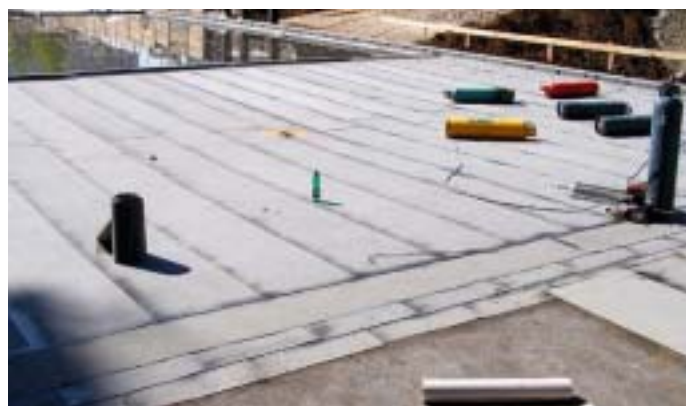
Poriment PS – 500, natavená hydroizolace, v pozadí zátopová zkouška
