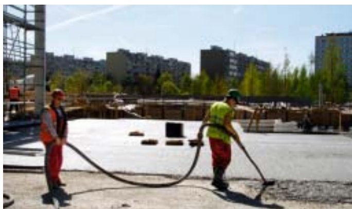
Poriment PS – 500, lití do spádu
