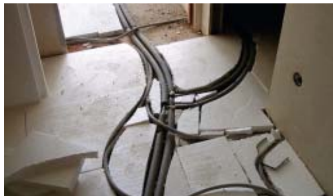
Původní technologie, vyřezané desky polystyrenu
