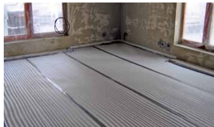
Obr. 2: Celoplošně položená kročejová izolace (podklad Poriment)
