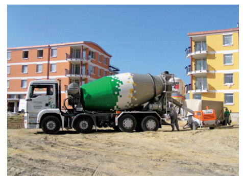
Čerpání dieselovým čerpadlem
