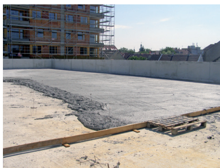
Poriment, spádová vrstva ploché střechy
