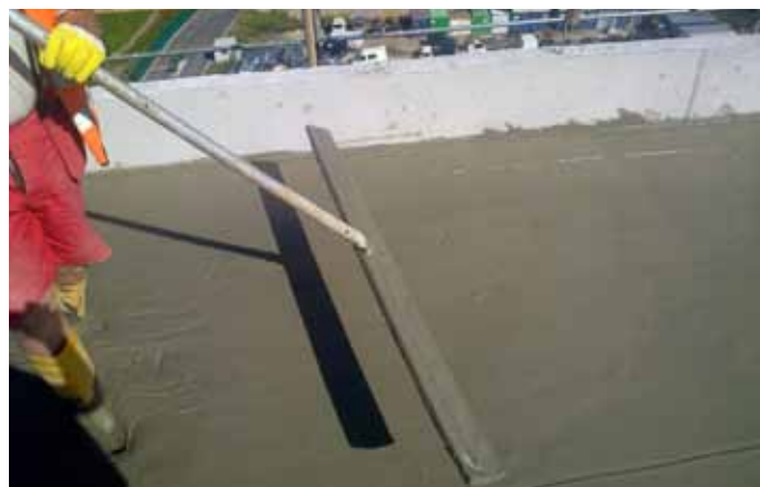
Obr. 4: Ukládání Porimentu® WS 700
