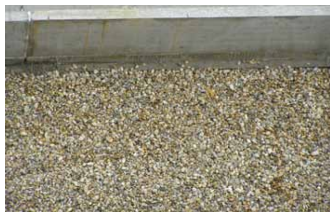
Obr. 8: Zatížení izolace kačirkem
