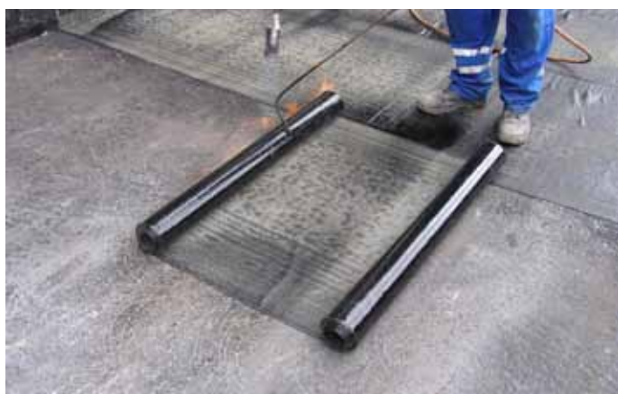
Obr. 7: Natavování izolace
