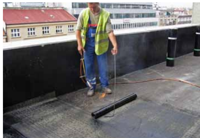
Obr. 6: Natavování izolace
