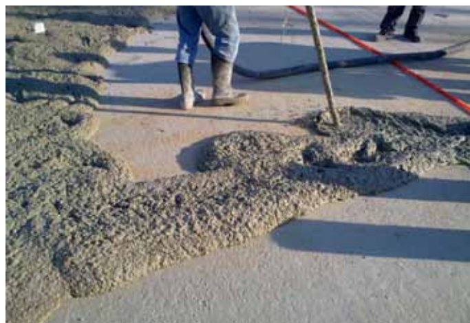
Obr. 2: Ukládání Porimentu® PS 500
